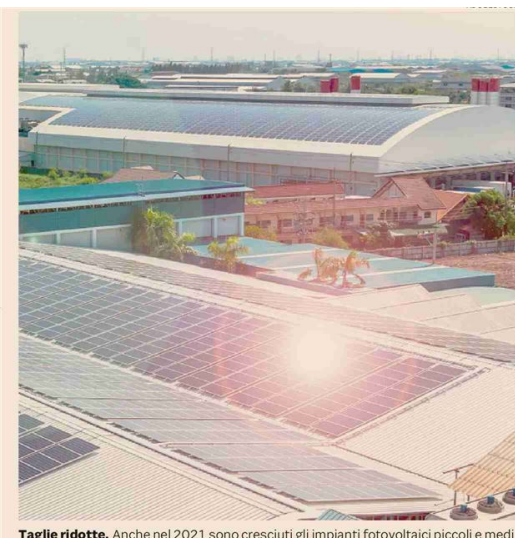
Taglie ridotte. Anche nel 2021 sono cresciuti gli impianti fotovoltaici piccoli e medi
